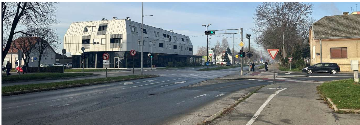
Raskrižje 2 – početak dionice 2
