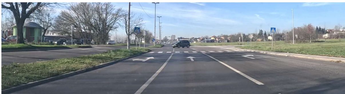
Raskrižje 6 – Zagrebačka ulica i Ulica Andrije Kačića Miošića
